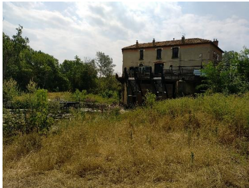
Station hydroélectrique de Ferrioles - 2022
